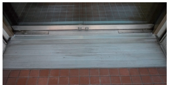
溝付き金属製下地(泥落とし)の一部をカットしてコの字型のアルミバーを取付。
