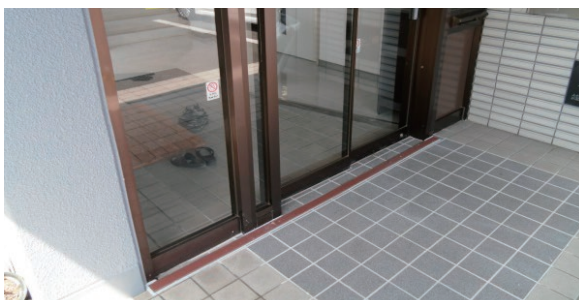
タイル目地の不陸調整(SUSフラットバー取付) ※不陸が大きい
